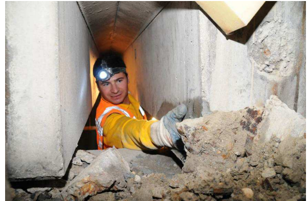
Bild 5 Betonsanierung in engem Raum
