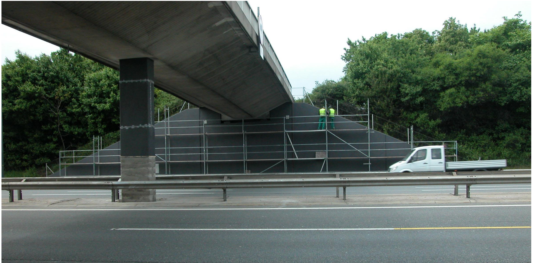
B 2134 – WIDERLAGER & MITTELSTÜTZE: CAS VERBUNDANODE + PRIMÄRANODEHOHE
