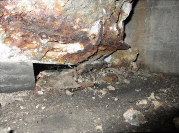
Bild 1 Chloridinduzierte Korrosion im Bereich der Bügel- und Langsbewehrung
