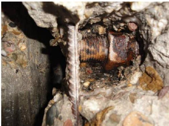
Bild 2 Oberflächige Korrosion im Bereich der Spanköpfe
