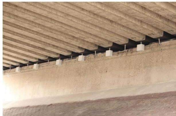
Bild 6 KKS-System nach der Ausführung mit Monitoringseinheiten pro 3 Träger
